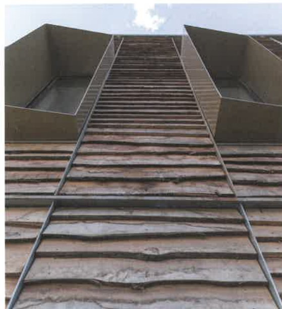
↑ Bardage en lames de châtaignier non délignées.
